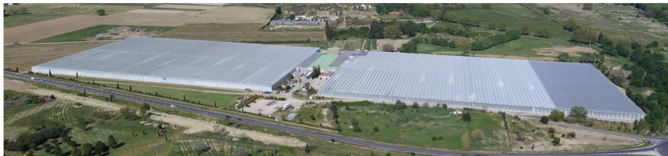
☞ Photographie 20 : Vue aérienne des Serres de la Coopérative Agricole Sud Roussillon
